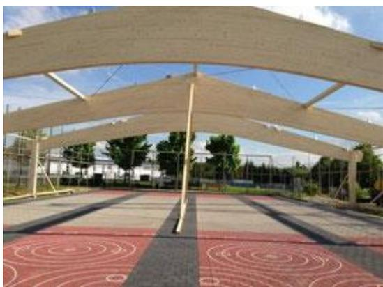
Überdachung der Stockbahnen mit Kosten von ca. 110 000 € wurde fertiggestellt. Im Zuge der Überdachung wurde der Anbau des Stockhäusls mit erledigt. In Eigenleistung wurden Erdarbeiten, Pflasterarbeiten, Beleuchtung und die Schließung des Giebels durchgeführt. Erweiterung der überdachten Fläche hinter den Bahnen wurde im Zuge der Überdachung mit durchgeführt. Die Kosten hierfür teilen sich Stockschützen und Hauptverein
